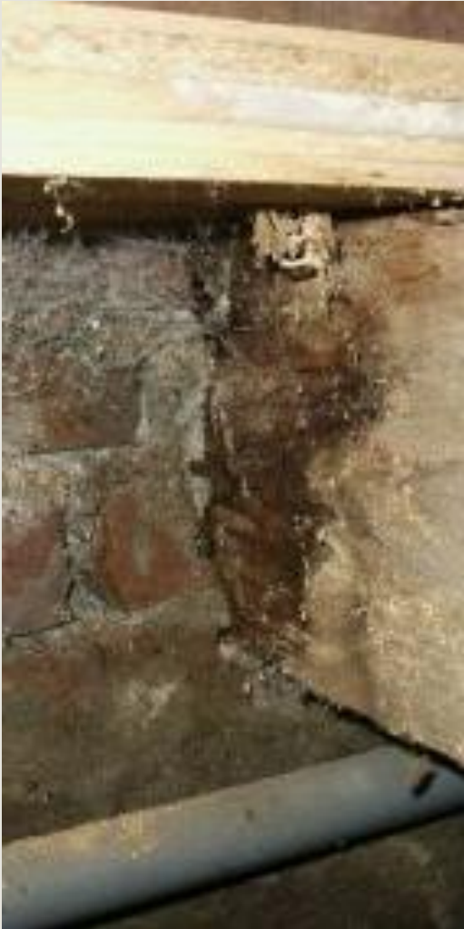
Exfiltration d'air chaud humide par les têtes de poutres
